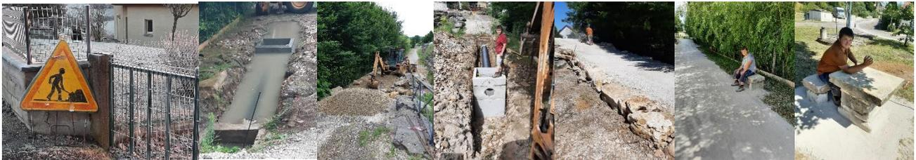
Le premier « vrai chantier » de 2022 fut la réfection du puits perdu au bas de la rue du Coteau. Pour remédier au problème, Pascal a dû faire une tranchée filtrante. Nous avons profité des travaux pour rendre plus accessible le passage des piétons, poussettes ... et déposé bancs et table pour le plus grand confort des promeneurs.
